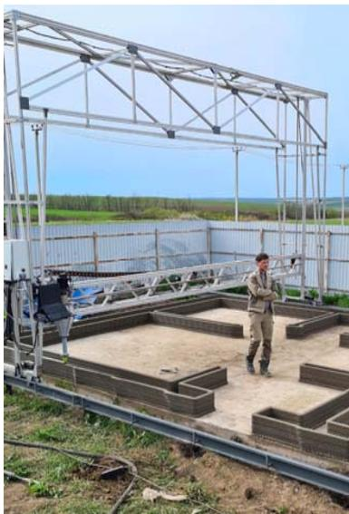
Рис. 2. 3D принтер «Gantry-8416»
