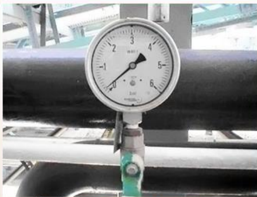
Прибор для измерения давления газа в технологическом трубопроводе
